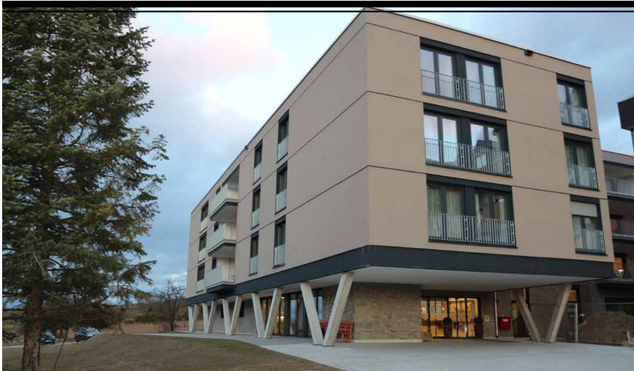
Altenpflegeheim, Friesenheim, weisenburger bau
